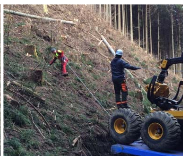
ストローロープ・主索張り
